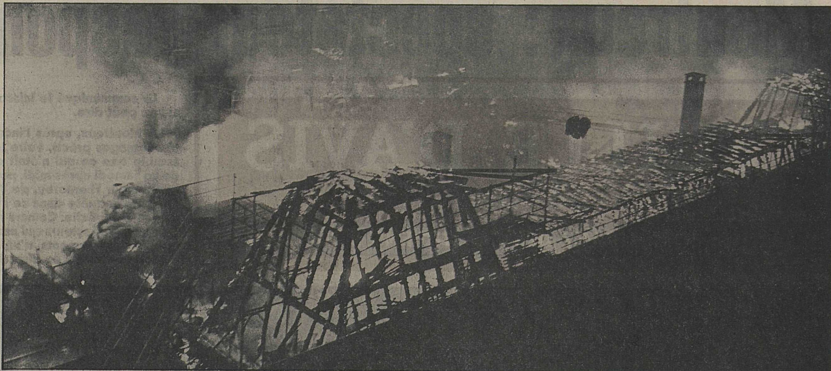
Toute la toiture du bâtiment du casino est la proie des flammes au début de la nuit.
