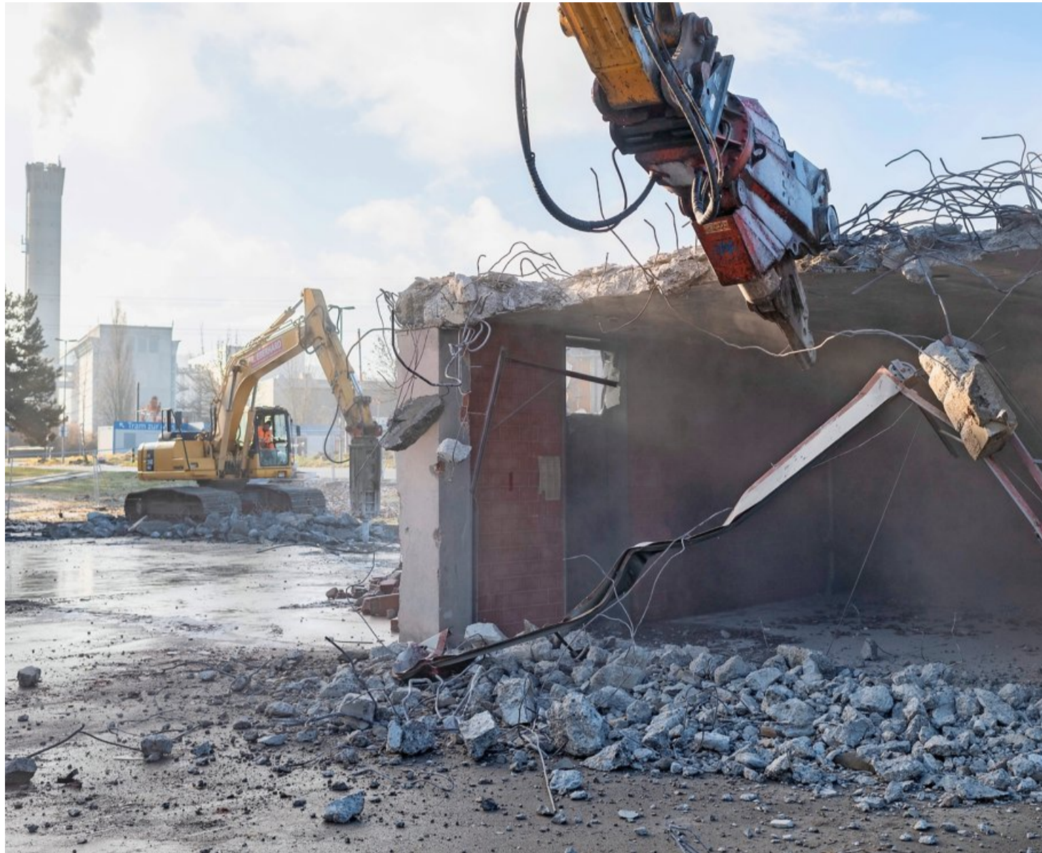
Das Maul des Baggers frisst sich durch die Decke und legt Armierungseisen frei, die teils in Handarbeit von Stein und Beton getrennt werden müssen.
