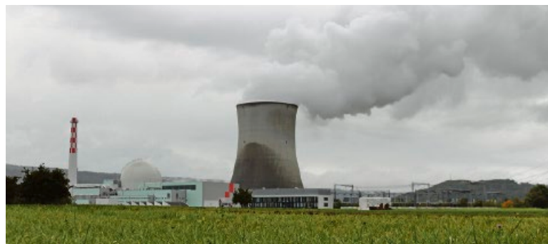
Das KKW Leibstadt produziert Strom für zwei Millionen Haushalte. Bilder: pmo
